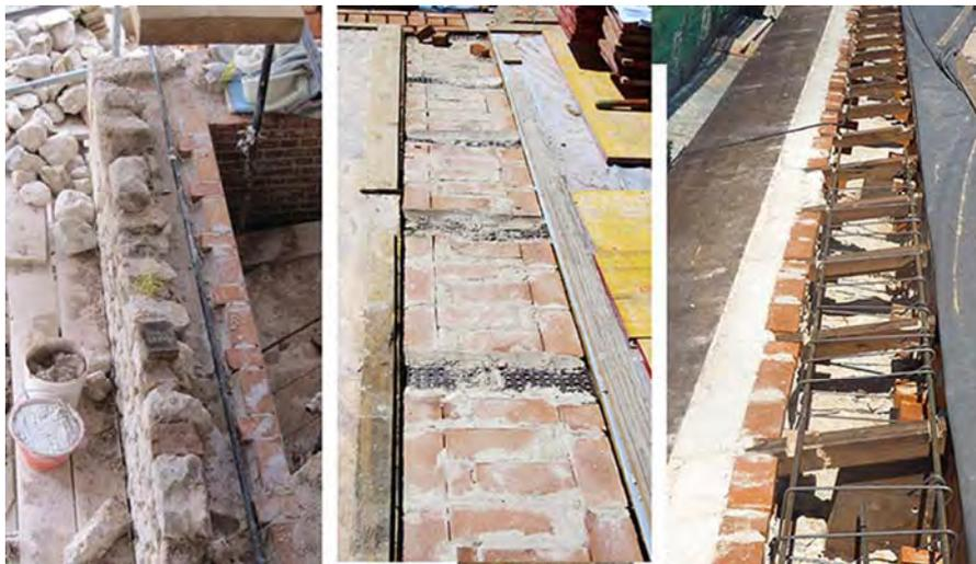
Fig. 4 – Alcuni interventi con cordoli in muratura armata rilevati nella ricostruzione del cratere aquilano - Fonte: foto dell'autore
